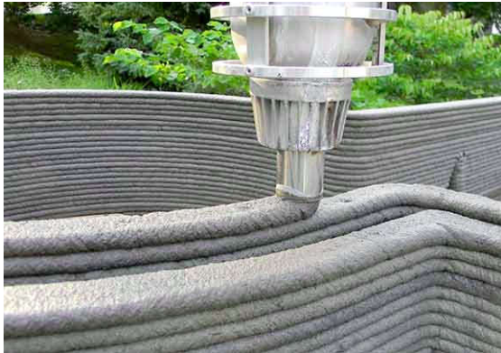
Thi công xây dựng với máy in 3D
